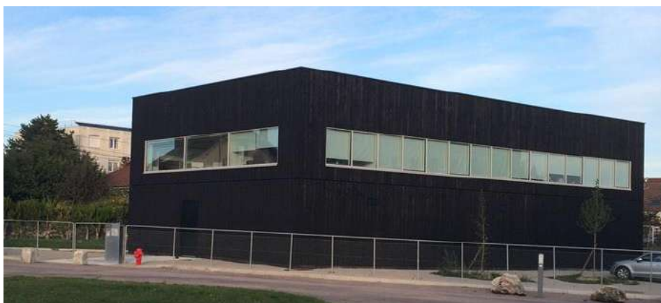
Figure 1. Le Green Datacenter du site dijonnais
